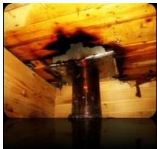
недостаточные разделки дымовых труб в местах их прохождения через деревянные перекрытия, а также малые отступки - расстояния между стенками печи и деревянными конструкциями перегородок и стен дома;
